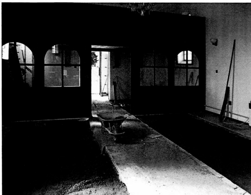
A betonlap készítése
