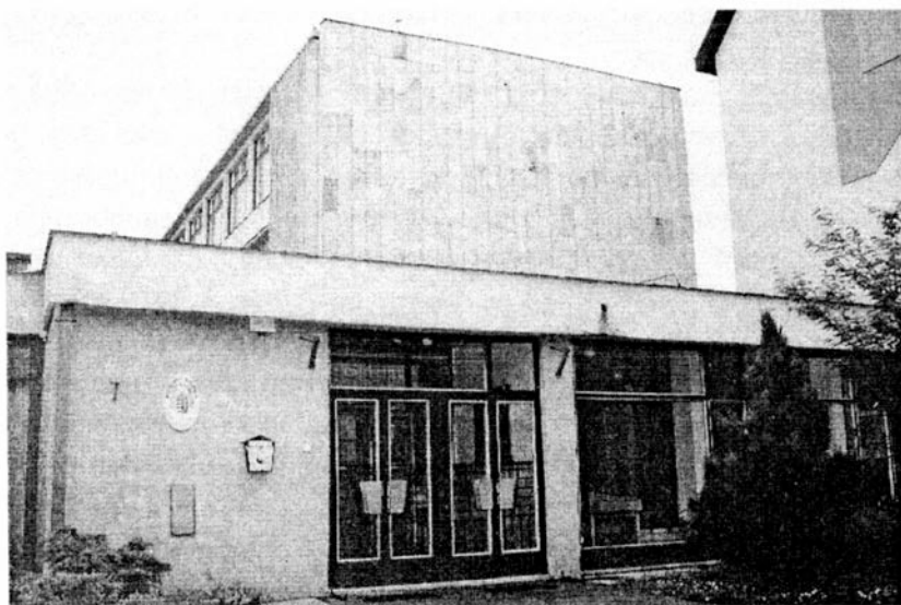
A Bárdos Lajos Általános Iskola főbejárata
